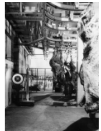
Blick in den Vorkühlraum des Kühlhauses (1952)
