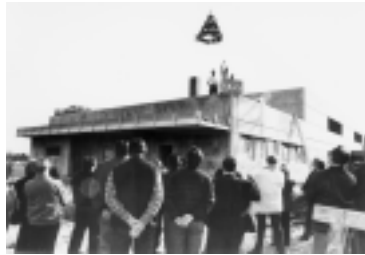
Richtfest für den neuen Schlachthof im Ortsteil Burgfarrnbach im April 1991.
